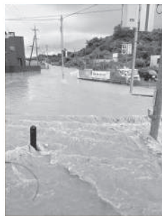
【写真5 道路の冠水】
